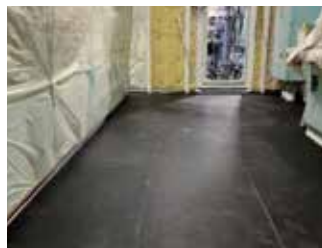
①制振材施工
