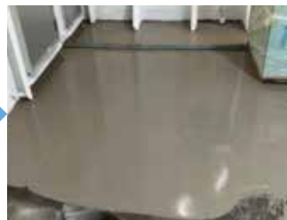
②デッキコンポジット(1層目)施工
