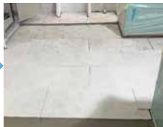
③不燃ボード施工
