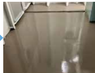
④デッキコンポジット(2層目)施工
