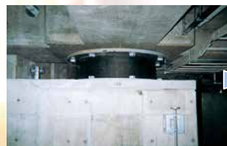
丸形積層ゴムの「護免火」耐火被覆工事
