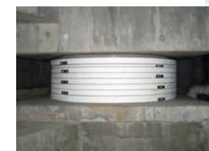
丸形積層ゴムの「護免火」耐火被覆工事
