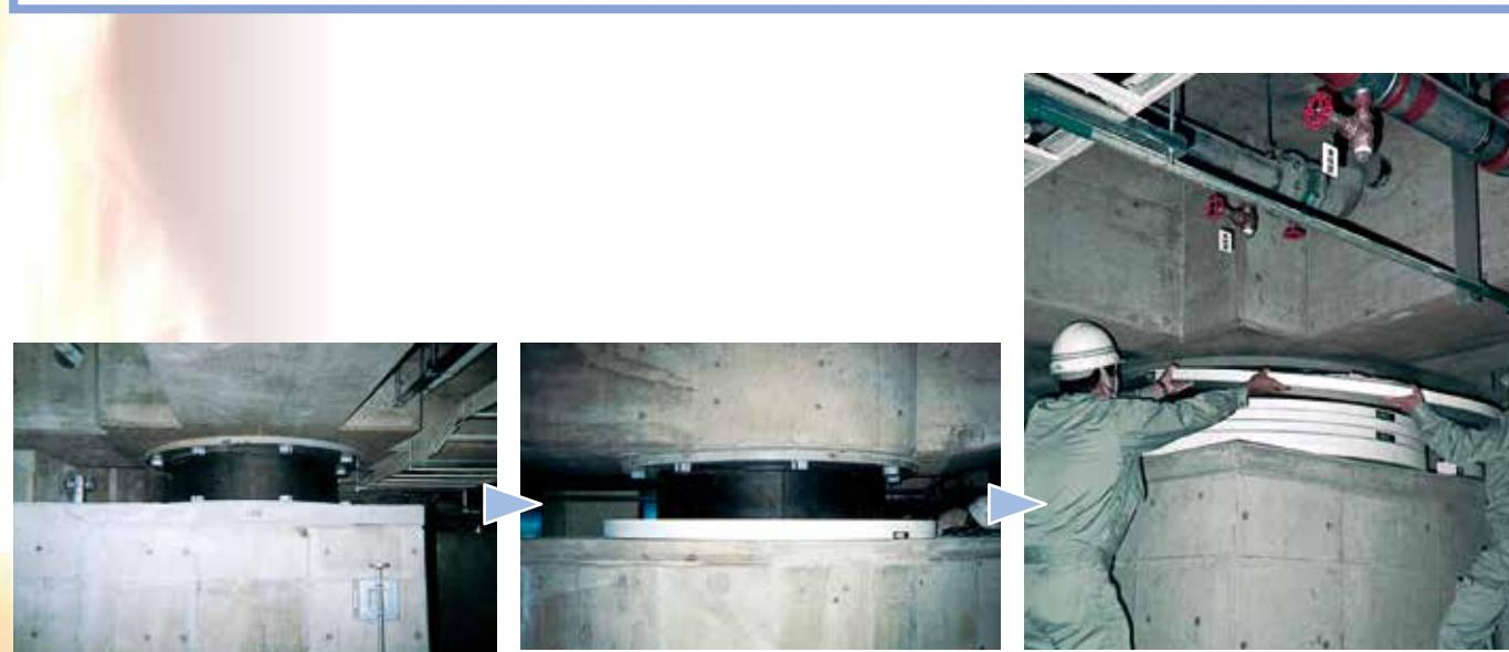
丸形積層ゴムの「護免火」耐火被覆工事
