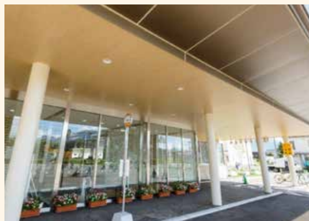
●役場車寄せ 軒天施工例 (接着張り工法)
