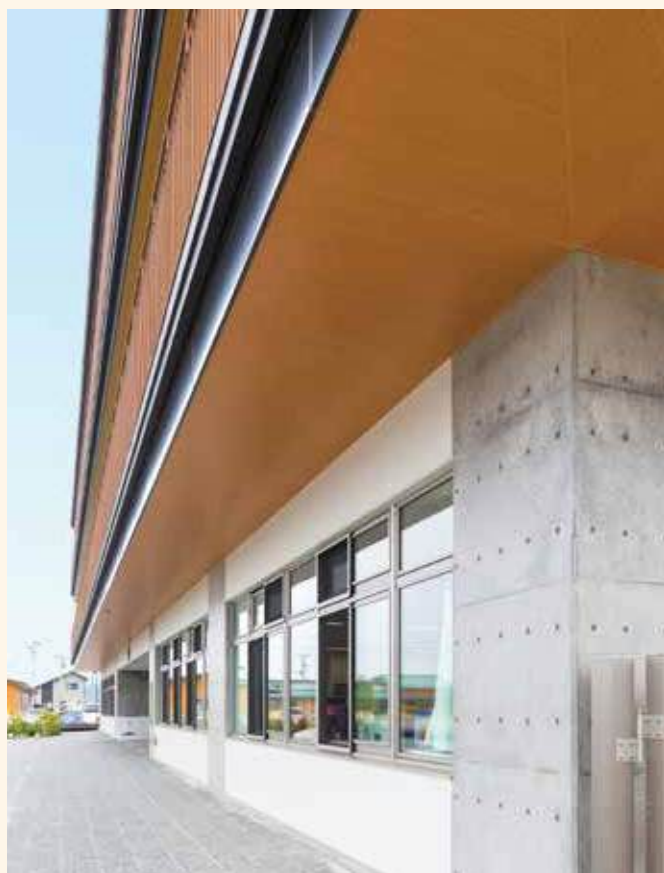
●学校施設 軒天施工例 (接着張り工法)
