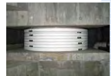
丸形積層ゴムの「護免火」耐火被覆工事(既設ビル)
