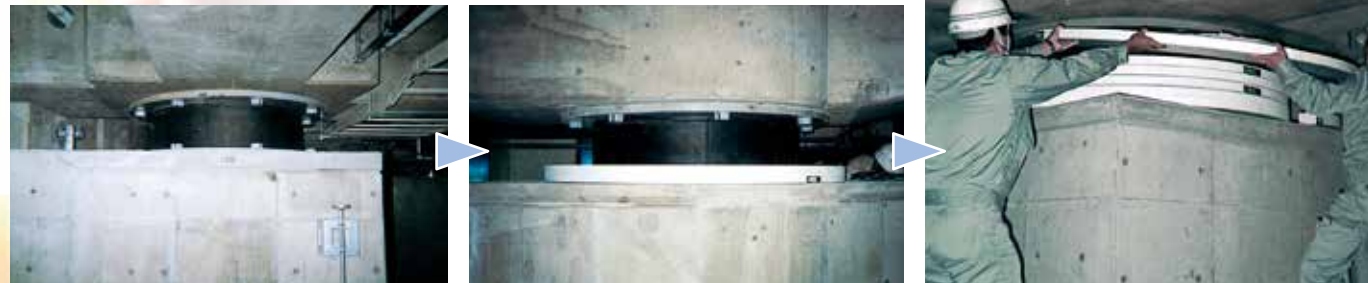
丸形積層ゴムの「護免火」耐火被覆工事
