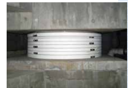
丸形積層ゴムの「護免火」耐火被覆工事
