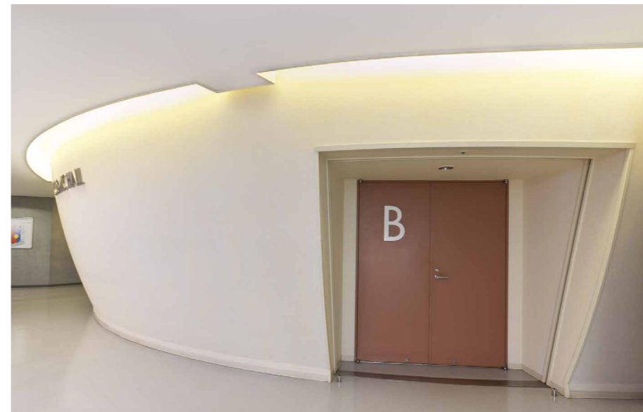
大阪 Mode 學園、HAL 大阪綜合校舍 球體外部 內牆 FG Board
