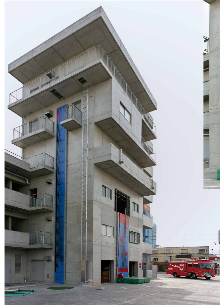
東大阪市消防局 訓練用牆 Guard Panel N 使用於座椅垂降訓練等
